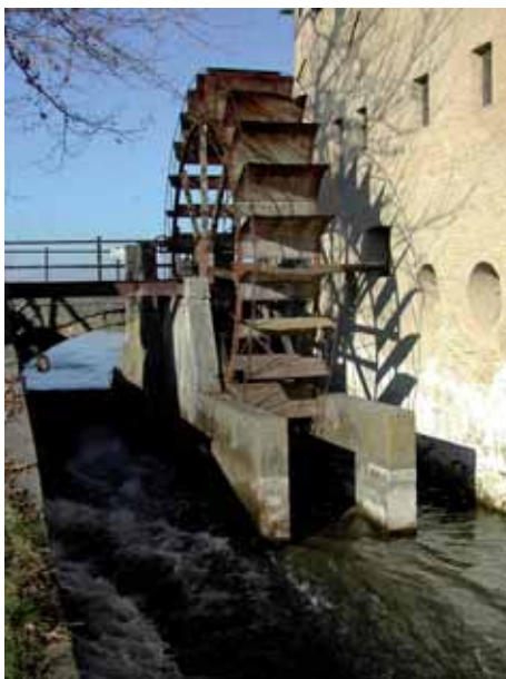
Mulino con la ruota alimentata "da di sotto"
