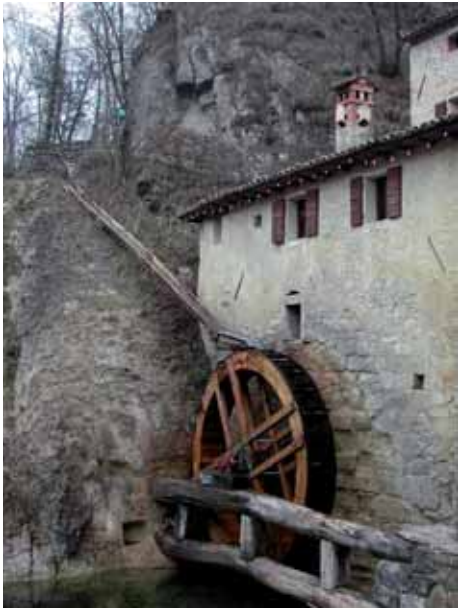
Molino con la ruota alimentata "da di sopra"
